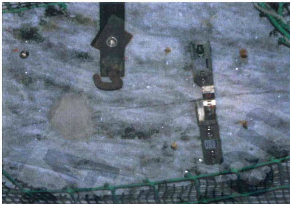
Bild 1: Ostfeld -372 mNN Sohle - Firste des Durchhiebs 4 zum Abbau 2 – Rissfläche an der Firste mit Fissurometer (CG188F) Stand: 16.01.02
